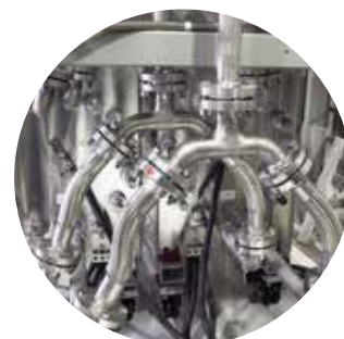
SUS316L を使用したプロセス配管
